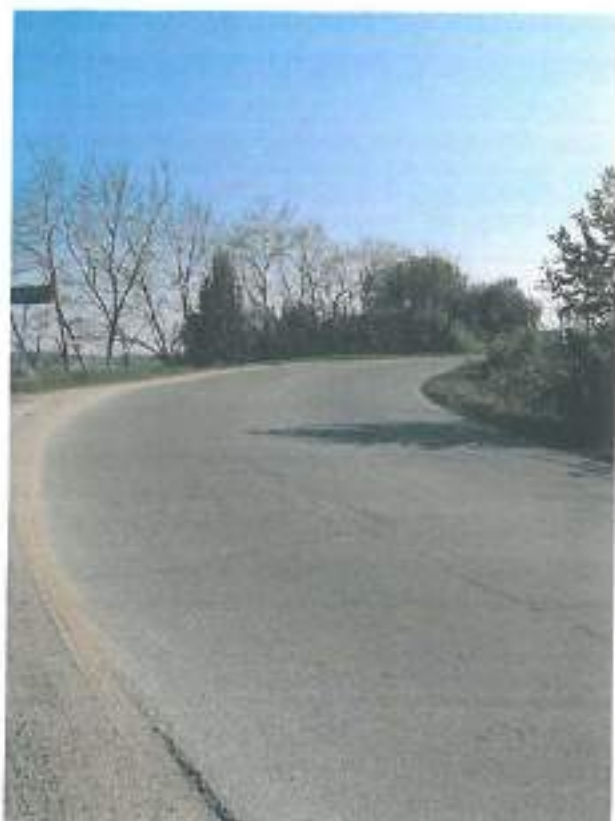
Foto nr. 7 - habitate caracteristice amplasamentelor investitiilor de pe arealul ROSCI0236
