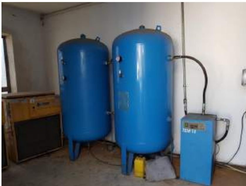
Figura 9. Compresor, Butelii de aer comprimat pentru curățarea mașinilor de injecție
