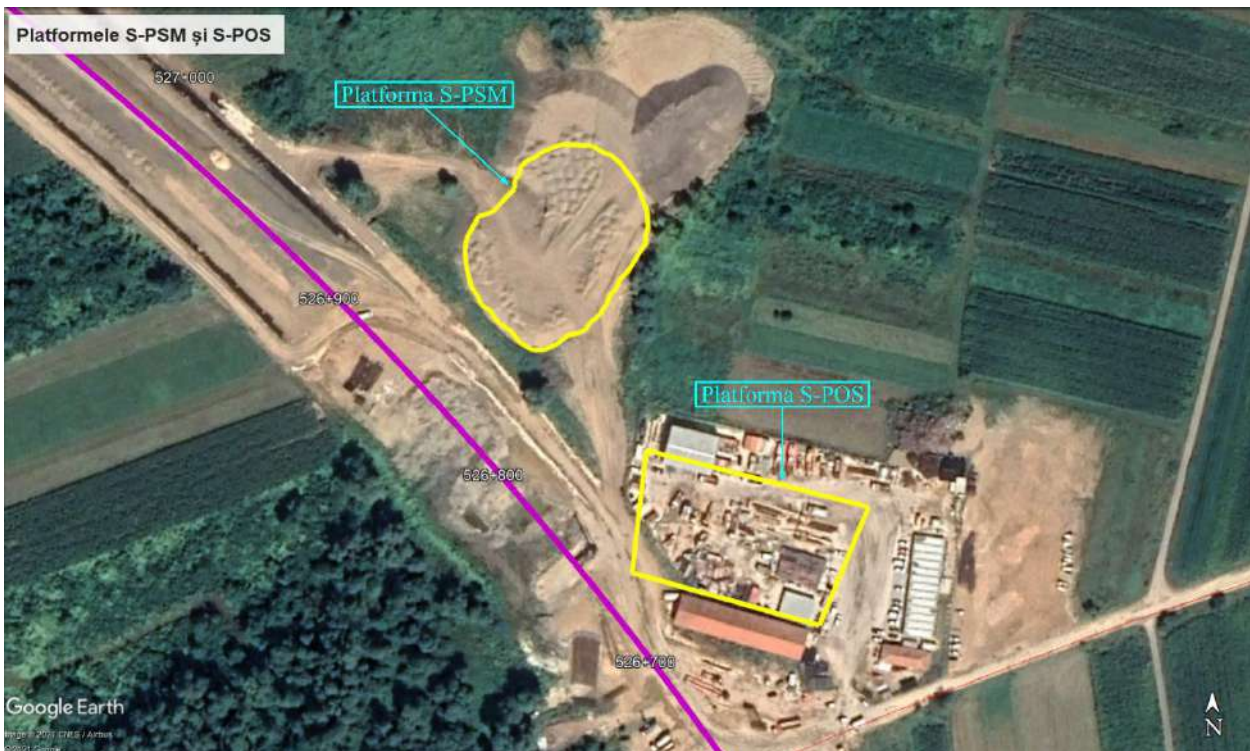
Figura III.3. Plan de amplasament pentru platformele S-PSM și S-POS, jud. Hunedoara – vedere din satelit
