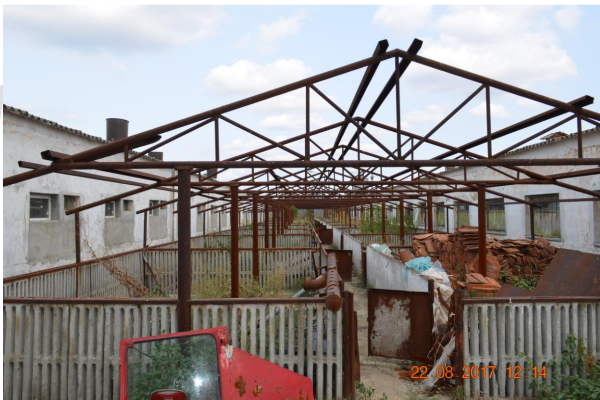
Foto 1. Padoc supus transformarii
