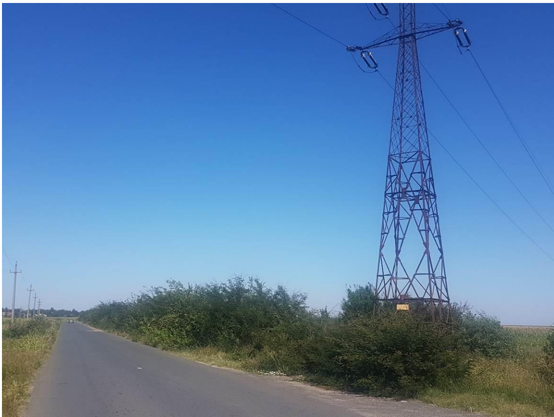
Linie de înaltă tensiune ce intersectează situl în zona localității Armășești– foto Gabriel Vânău
