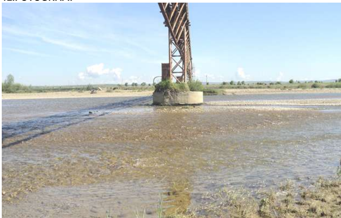
Foto - Râul Trotuș - Pila nr. 5
