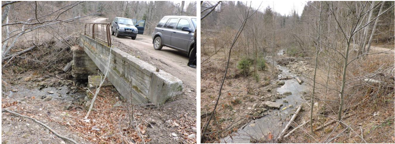
Figura 35. Albia pârâului Lepșuleț în amplasamentul proiectului (pod la km 72+271)
