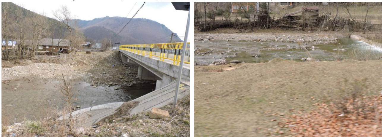
Figura 36. Albia pârâului Lepșuleț în amplasamentul podului de la km 73+000 (asupra căruia nu se va interveni în cadrul proiectului)
