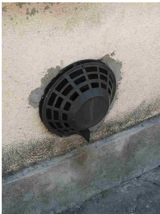
Dispozitiv de eliminare a gazelor arse
