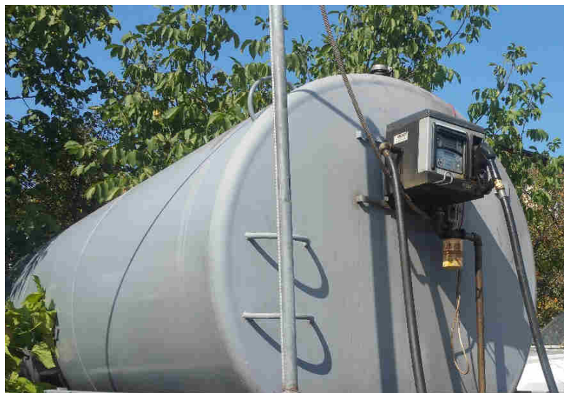
Rezervorul de motorină (capacitate 14.600 l)
