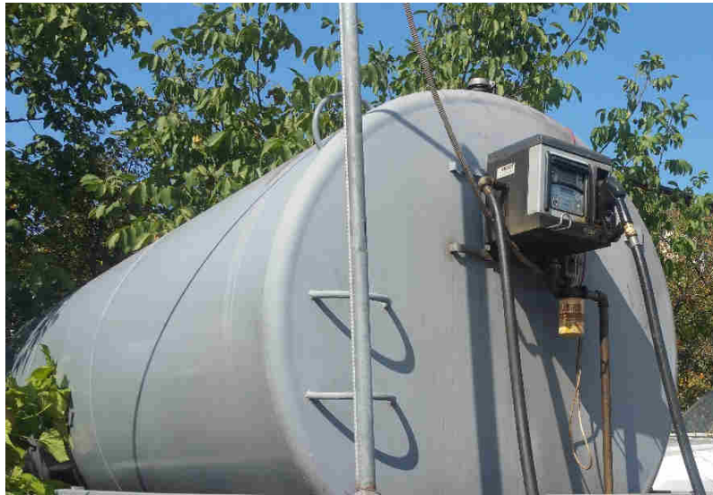
Figura nr. 6. Rezervorul de motorină (capacitate 14.600 l)
