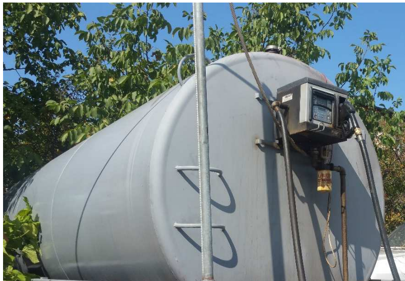
Figura nr. 6. Rezervorul de motorină (capacitate 14.600 l)
