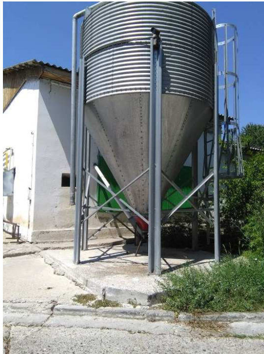
Figura nr. 9. Buncăr exterior de furaje
