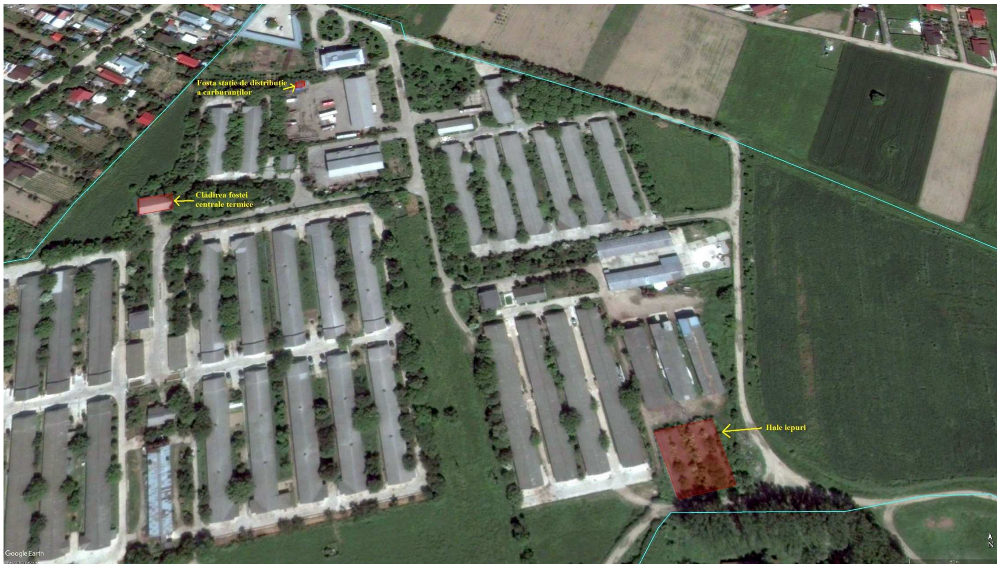
Figura nr. 8. Clădirile nefuncționale de pe amplasamentul Fermelor de păsări – Platforma Golești (Sursa: Google Earth)
