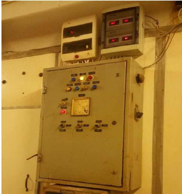
Figura nr. 16. Sistemul de monitorizare și reglaj a parametrilor din incubatoare – clădirea veche
