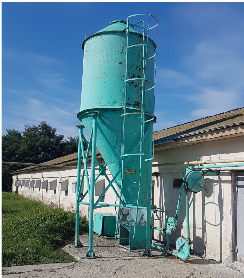
Figura nr. 25. Buncăr exterior pentru depozitarea furajelor
