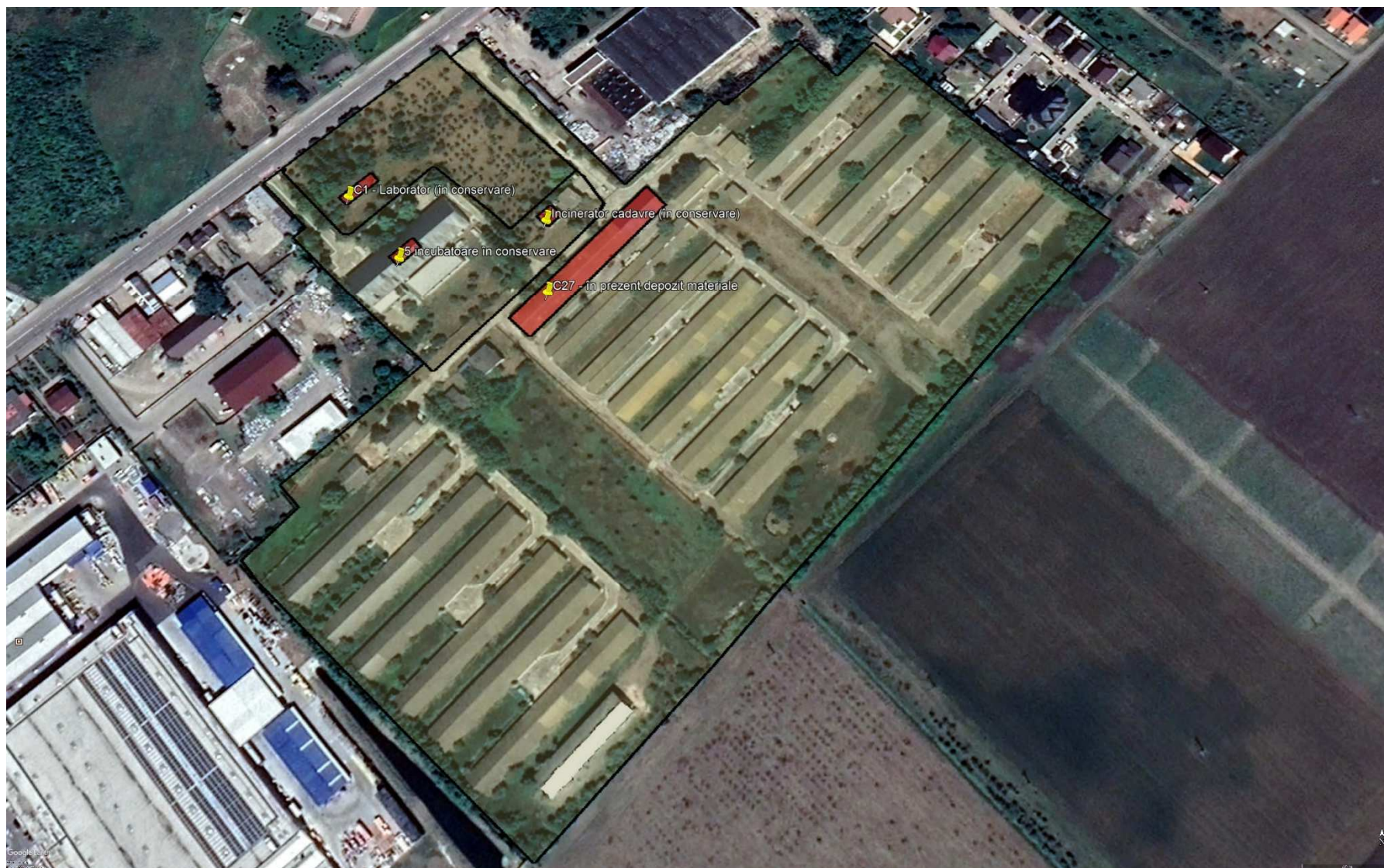
Figura nr. 23. Clădiri/instalații nefuncționale pe amplasament
