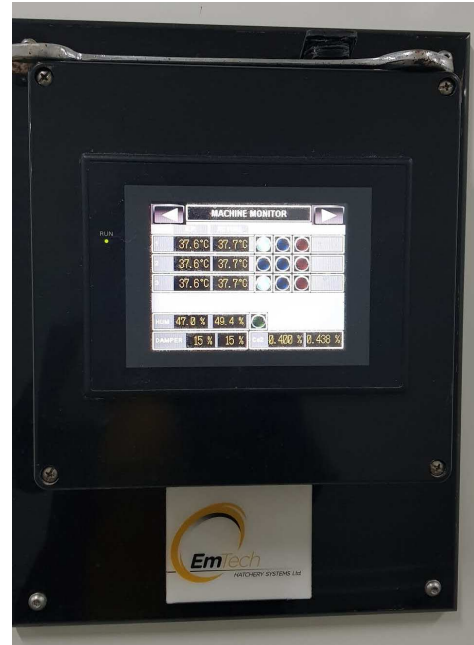
Figura nr. 17. Sistemul de monitorizare și reglaj a parametrilor din incubatoare – clădirea nouă
