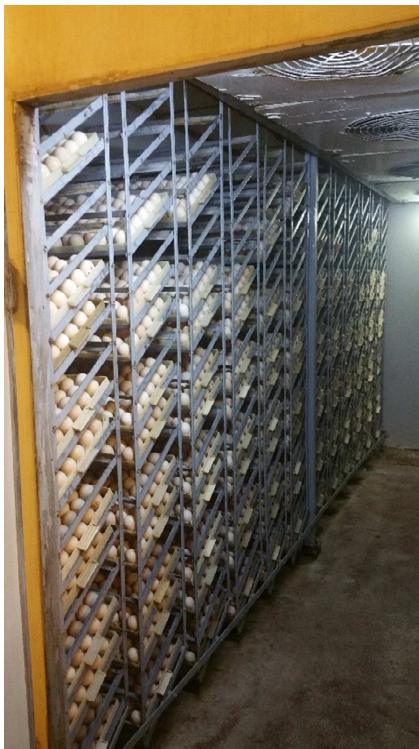
Figura nr. 14. Interiorul unui incubator din vechea clădire
