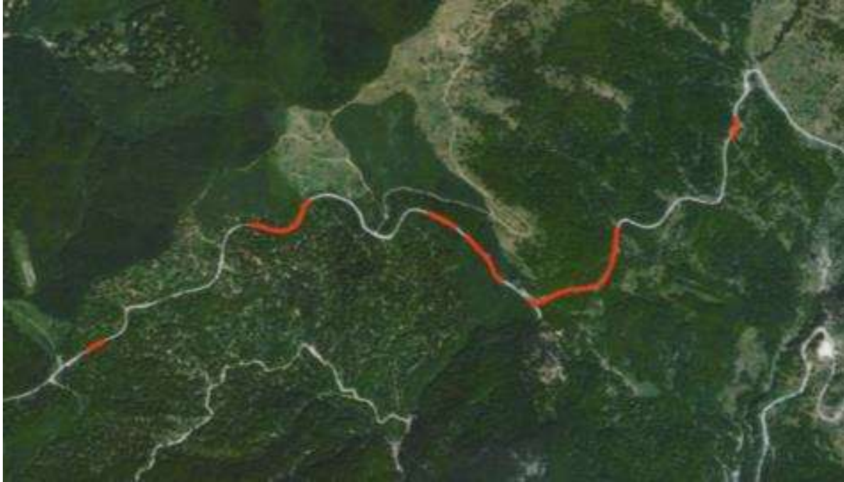
Fig..V1.4.2.4. Localizarea parapetelor de beton pe drumul DN 2D
