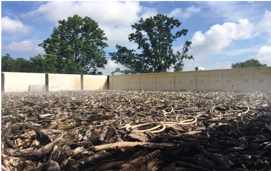
Figura nr. 8. Sistem de biofiltre în partea de sus a acoperișului reactorului
