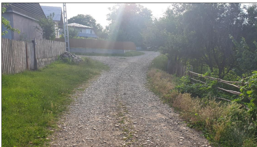
Foto 04. Situatie existenta strada Abisiniei
