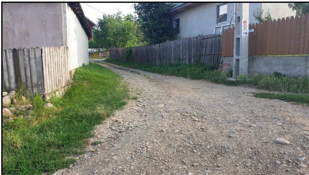
Foto 05. Situatie existenta Albinelor
