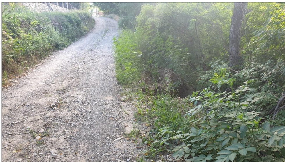
Foto 03. Situatie existenta strada Abisiniei
