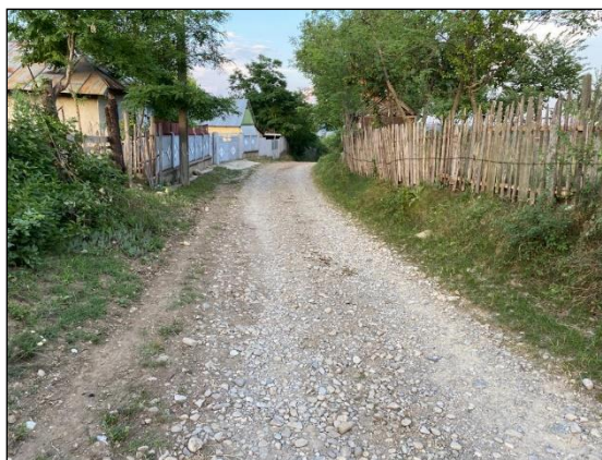
Foto 21. Situatie existenta strada Plopilor
