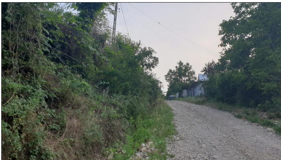
Foto 07. Situatie existenta strada Soarelui
