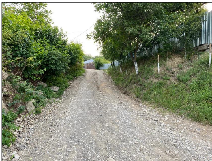
Foto 15. Situatie existenta strada Pinului(drum lateral)
