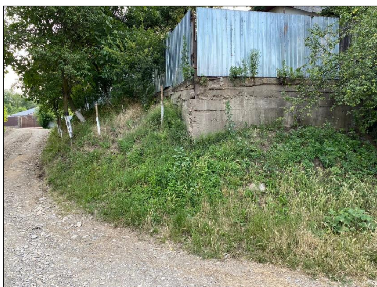
Foto 16. Situatie existenta strada Pinului
