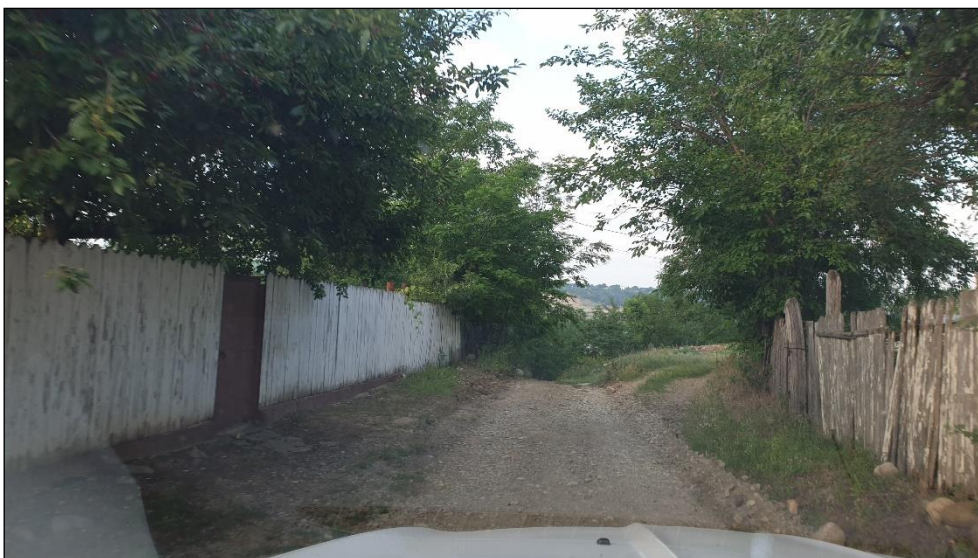
Foto 11. Situatie existenta strada Luminilor
