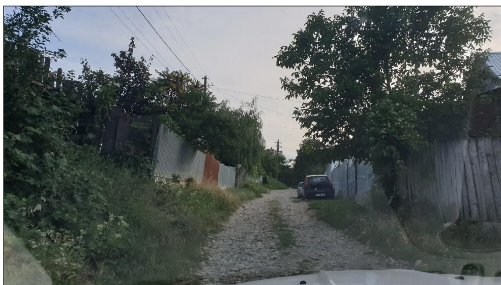
Foto 08. Situatie existenta strada Soarelui
