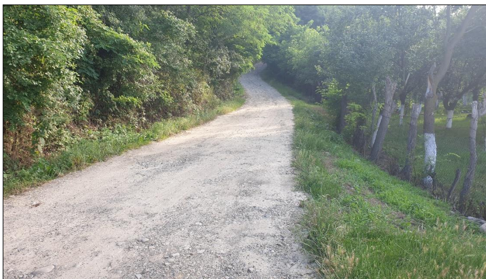
Foto 01. Situatie existenta strada Abisiniei
