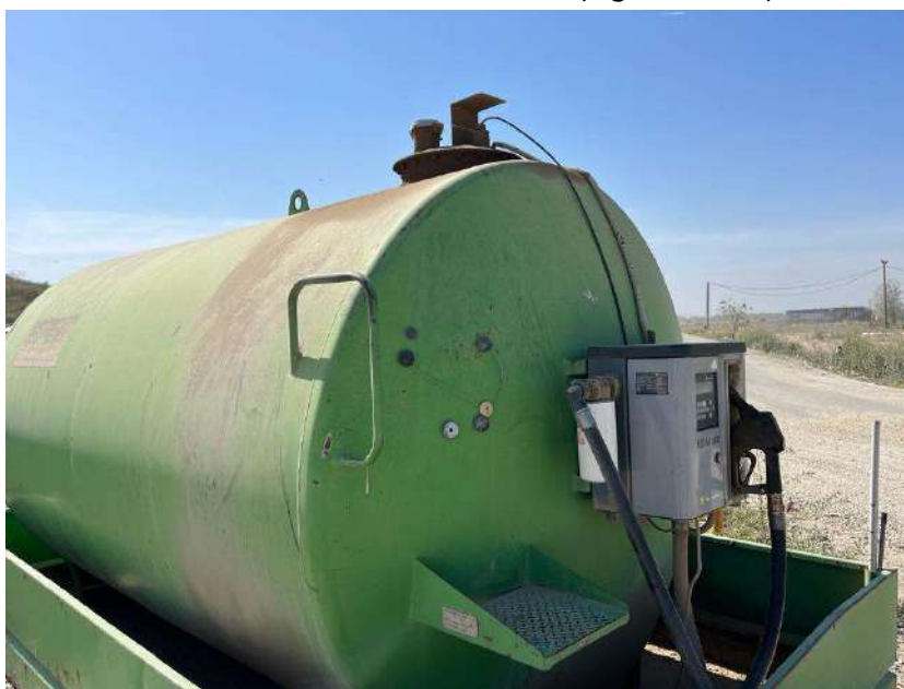
Figura nr. 2-5 Stație de alimentare cu carburanți
