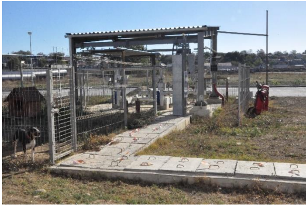
Zona rezervorului subteran de motorină
