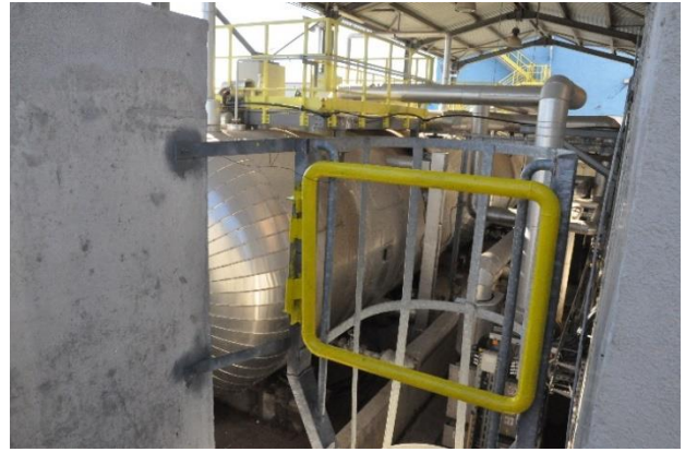
Rezervoarele de ulei amplasate în cuvă betonată
