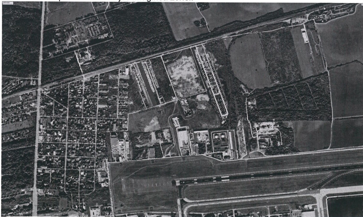
Locatia propusa pentru proiectul „AMPLASARE CONTAINER TIP BIROU P, PUT FORAT, BAZIN VIDANJABIL SI IMPREJMUIRE TEREN”
