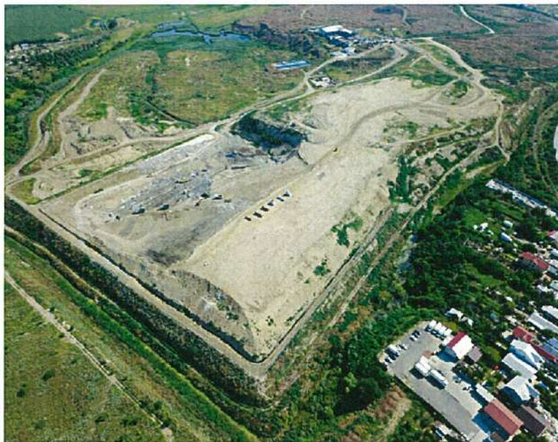
Depozitul conform celula nr. 2 si sectiunea activa - vedere de ansamblu
