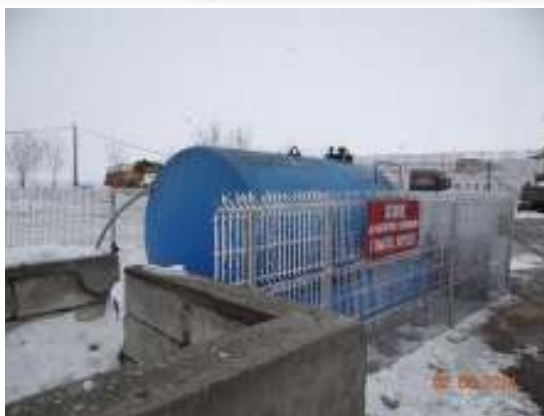
Figura nr. 2-4 Stație de alimentare cu carburanți (dreapta)
