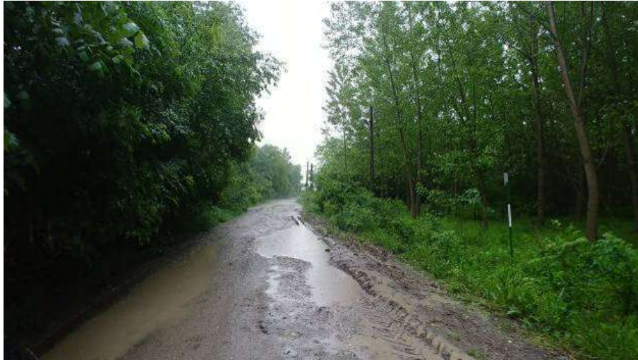
Fig 11 -12 Partea carosabila a drumului judetean DJ 101J cu multiple defectiuni. Se observa colmatarea sau lipsa dispozitivelor de colectare a apelor pluviale - zona 1+350
