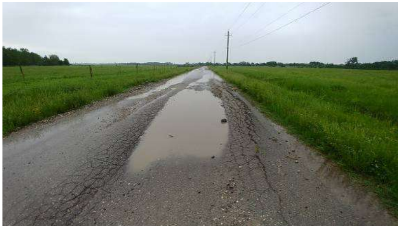
Fig 10. Partea carosabila a drumului judetean DJ 101J cu multiple defectiuni, incadrata cu acostamente din pamant - km 1+200
