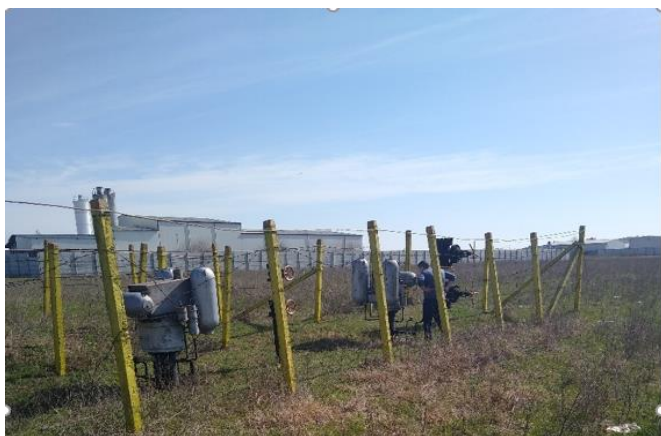
Foto 1. Înlocuirea robinetelor R9, R10 și refacerea cuplării SRM Măgurele, UAT Măgurele
