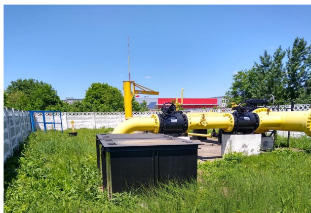
Foto 13 Extinderea împrejuririi Gara primire PIG Voluntari, UAT Afumați
