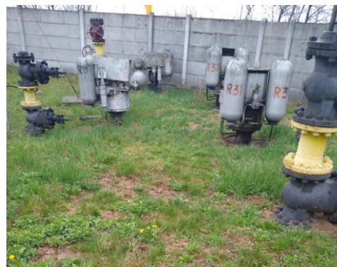
Foto 12. Inlocuire robinete R31, R30, R19, R18 ,UAT Afumați
