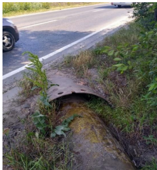
Foto 6. Înlocuire subtraversare DN CB, UAT Chitila
