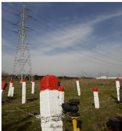
Foto 5. Dezafectarea și relocarea robinetului R1, UAT Buftea
