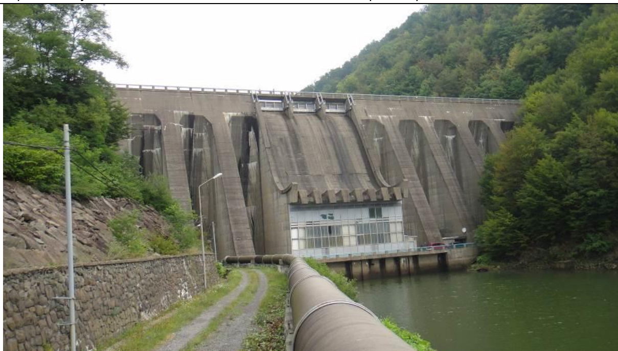
Foto nr. 22 Barajul Stramtoria-Firiza
