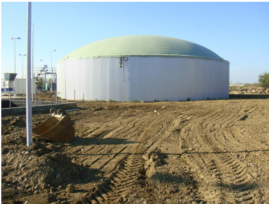
Figura nr. 12 - Digester anaerob
