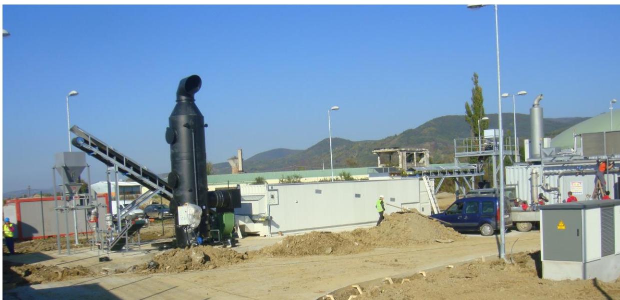
Figura nr. 16 - Ansamblu digester, transformator, cogenerator separator digestat solid/lichid, uscator cu banda, scrubber, instalație de insacuire
