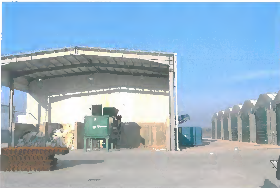
Fig. 10 – Detaliu din Stația de tratare mecano – biologică Sârbi
