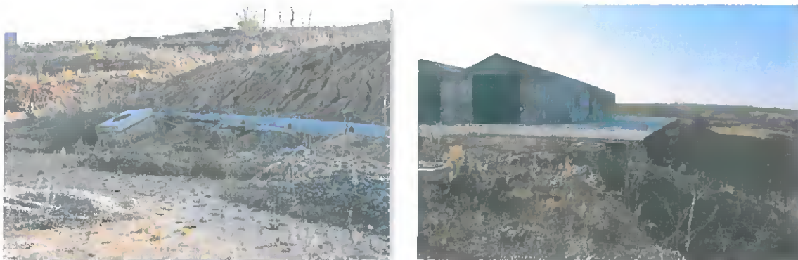
Fig. 14 – Procese de instabilitate a solului limitrof Stației de tratare mecano-biologică Sârbi
