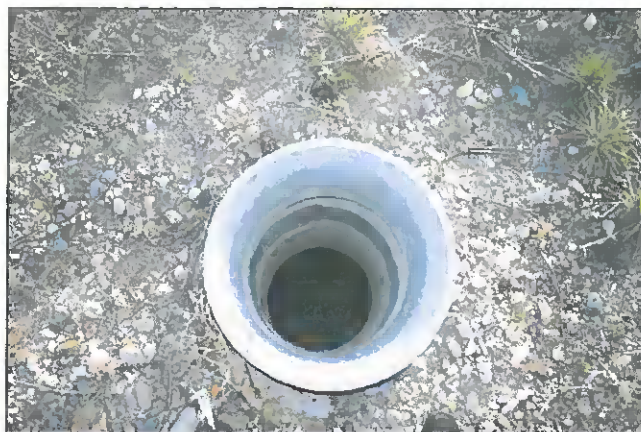
Fig. 7 – Detaliu foraj de monitorizare
