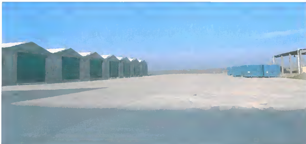
Fig. 11 – Detaliu celule pentru compostare din cadrul Stației de tratare mecano-biologică Sârbi
