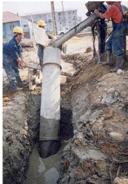
Ecran gel-beton faza de turnare
