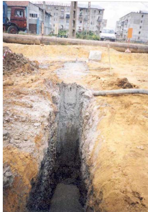
Ecran gel-beton faza de betonare
