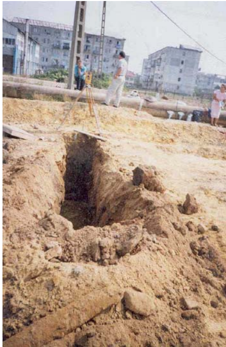
Ecran gel-beton faza de excavații
