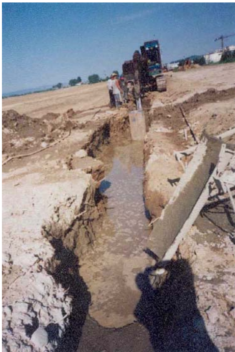
Ecran gel-beton fazele simultane excavare și betonare
