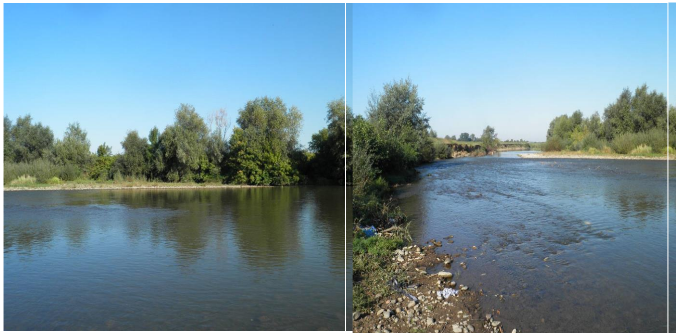
Foto nr. 3 Amplasament conductă transport Bozânta în zona de subtraversare a râului Lăpus
