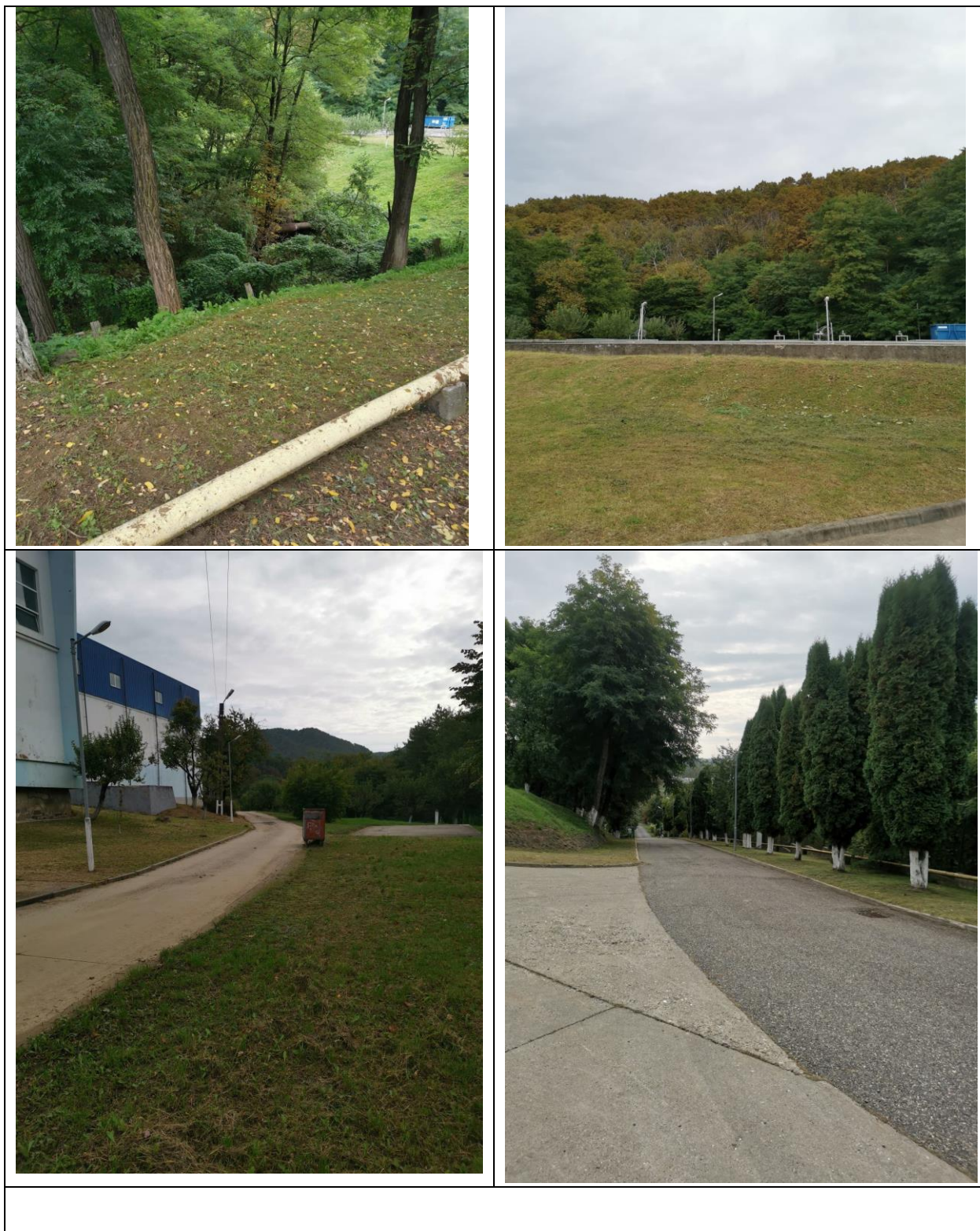
Foto nr. 5 Traseu conductă de transport apa (Gospodaria de apa Baia Mare)
