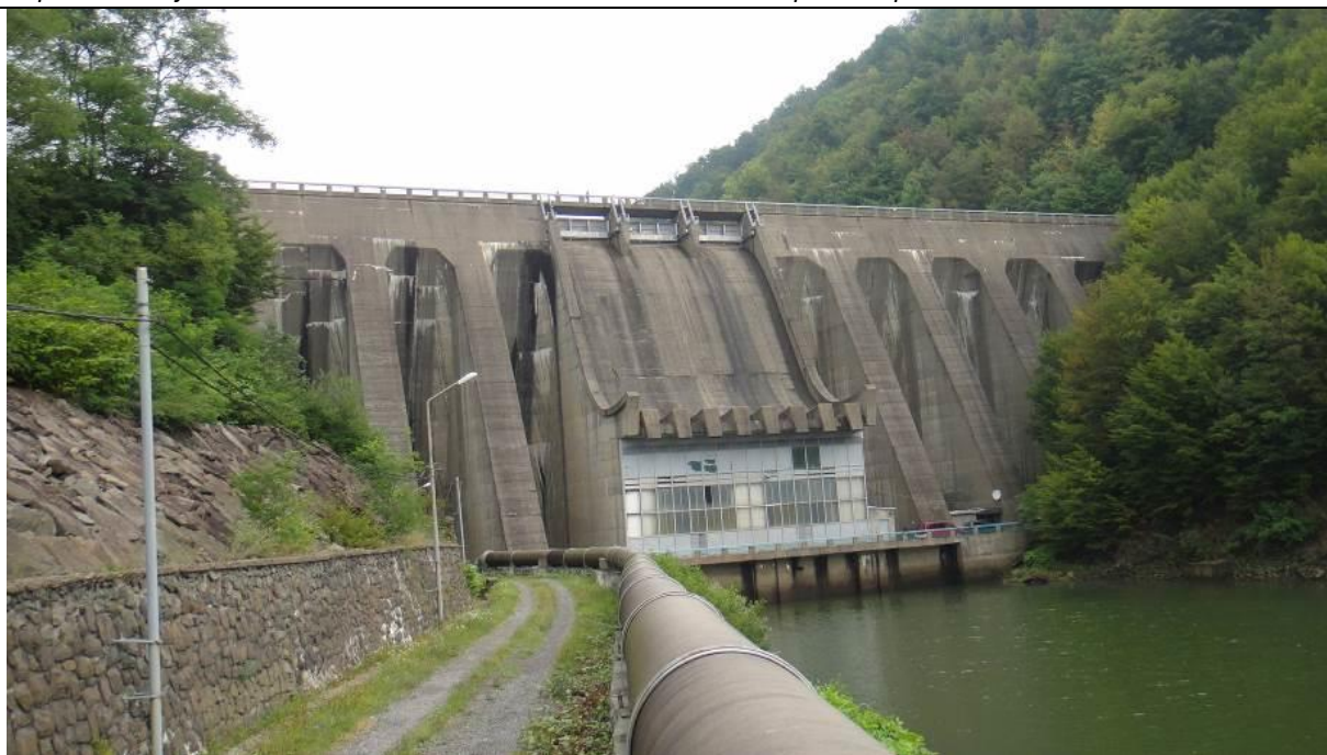
Foto nr. 23 Barajul Stramtoria-Firiza
