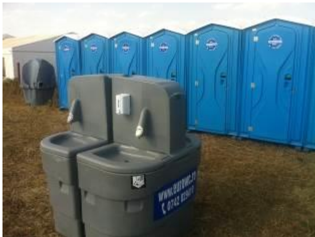
Figură 7 Modele de soluții de asigurarea a condițiilor de igienă pe amplasamente temporare (organizări de șantier, fronturi de lucru, etc.): toalete ecologice, cu bazin etanș, vidanjabil, tratat chimic; lavoare de spălare cu rezervoare etanșe ce asigură apa de spălare ce este apoi re-introdusă în rezervor distinct, etanș, vidanjabil (stânga); cabină de duș modulară cu rezervoare etanșe distincte: rezervor apă pentru spălare, rezervor etanș, vidanjabil pentru apa utilizată (dreapta)
