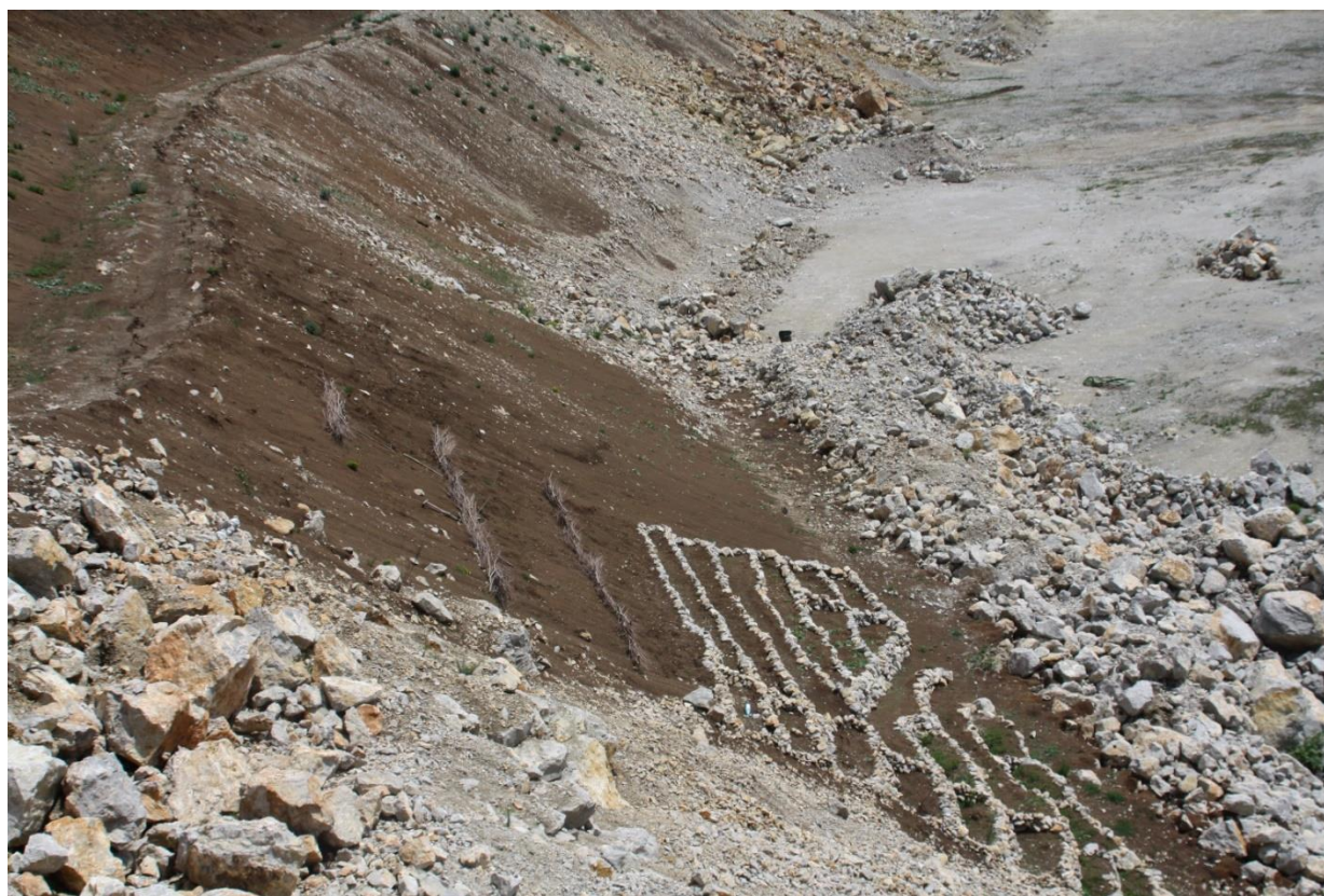
Figură 12 Cleionaje din material vegetal și terase din anrocamente
