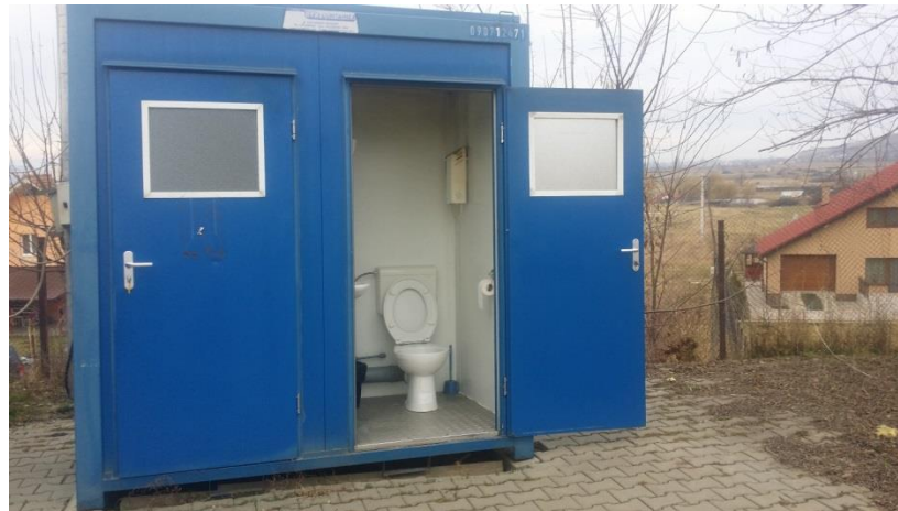
Figură 6 Container modular cu bazin vidanjabil, tratat chimic, dotat cu grup sanitar (toaletă și dușuri).
