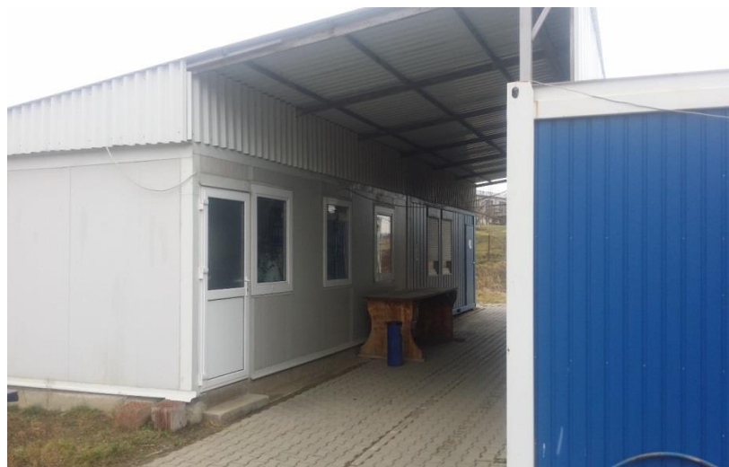
Figură 5 Model de organizare de șantier realizată din containere mobile
