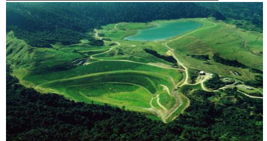
2001 – etapa de restaurare ecologică
