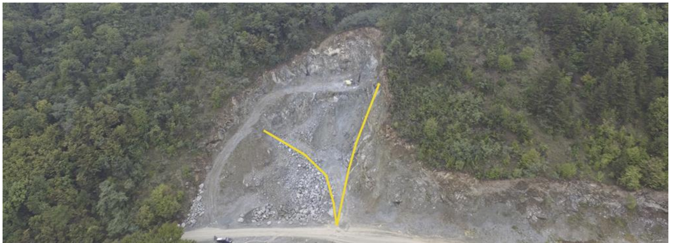
Figura 9. Aspectul zonelor la nivelul căreia se poate amenaja jgheabul (rostogolul) de evacuare inițială a rocii
