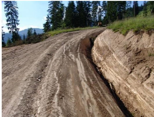
Figura 6. Ilustrarea impactului asociat unui drum forestier de exploatare; se observă ogașele profunde cauzate de fenomenele erozive, tasările generate de târârea arborilor și zonele extinse de afectare ca urmare a insuficienței pregătire a zonelor de schimbare a direcției
