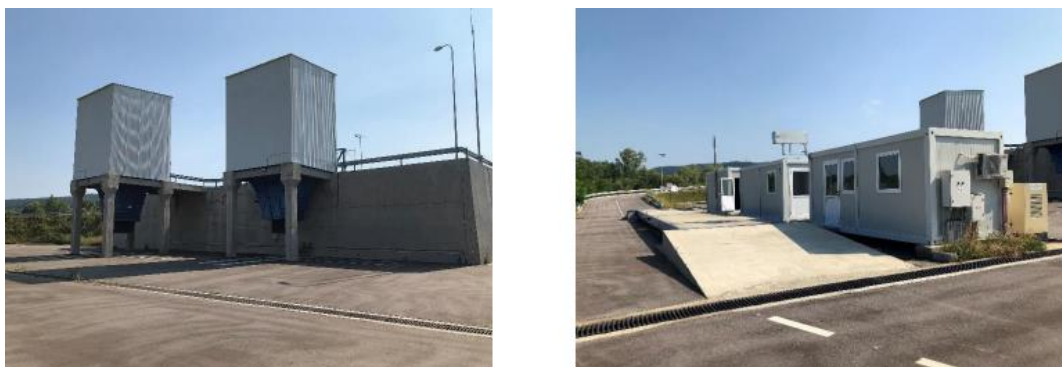
Figura nr. 17 –Stația de transfer Strehaia
