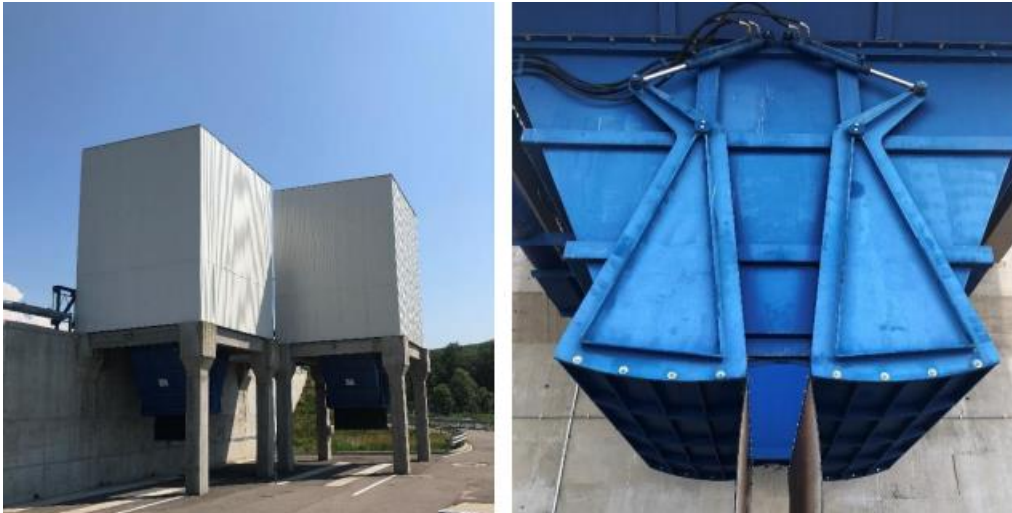
Figura nr. 16 –Stația de transfer Baia de Aramă
