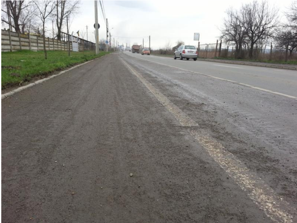
Fig.62 Particule sedimentate pe marginea carosabilului în special pe trotuar și pista pentru biciclete str. Libertății, Tîrgu Mureș ; această situație reprezintă un potențial de risc semnificativ pentru poluarea aerului
