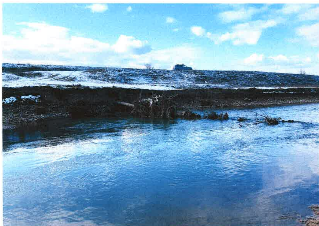
Foto nr. 2 - rau Moldova, loc. Timisesti - mal drept erodat si plutitori prinsi de conducta de transport gaze dezvelita
