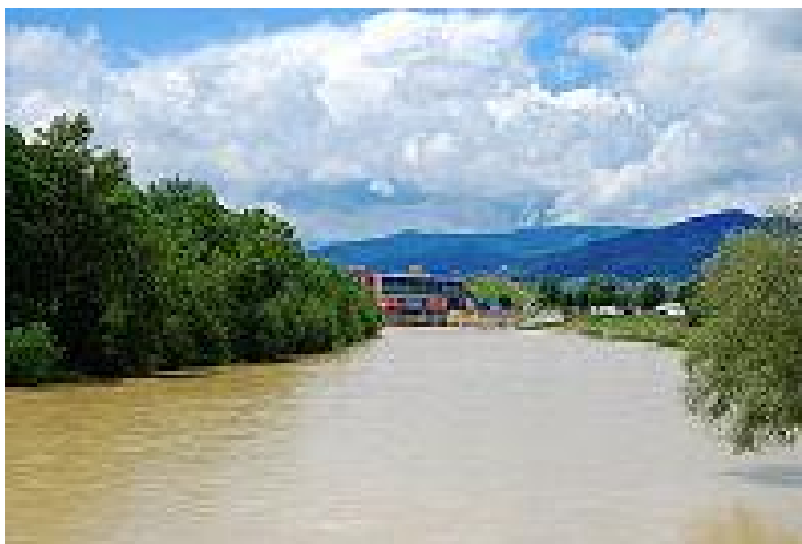
Râul Bistrița în aval de barajul de la Bâțca Doamnei
