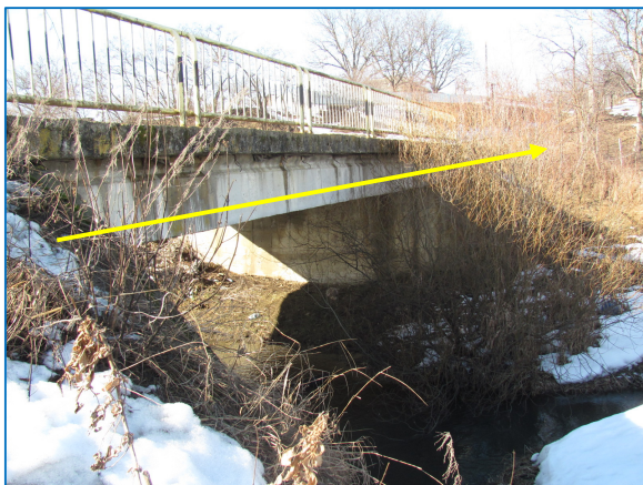
Supratraversarea râului Valea Neagră prin ancorarea conductei de distribuție a gazelor naturale ( — ) de Podul Cotu Luncii
