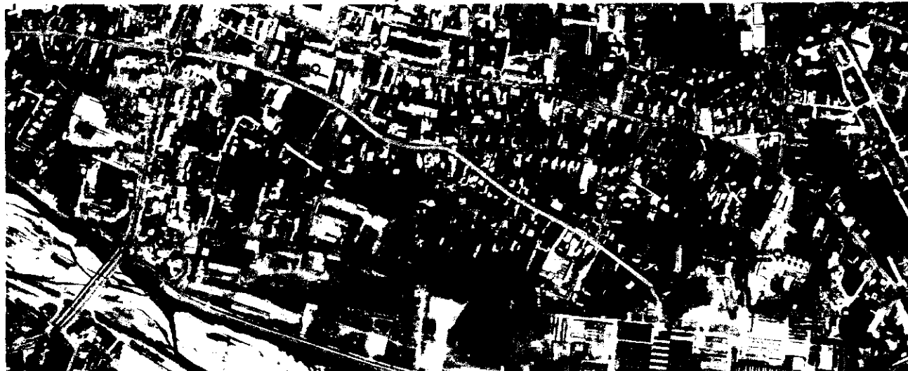
Fig. 1 - caile de circulatie adiacente
