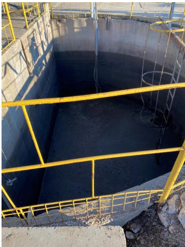
Batal nr. 1 reabilitat și bazin colectare dejecții mixte înainte de separare, nou realizat
