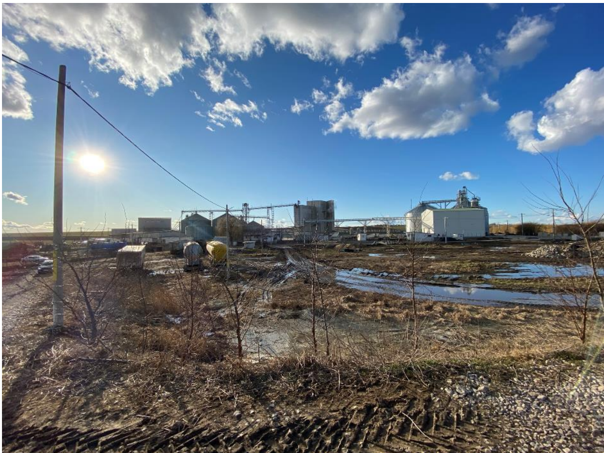
În stânga – FNC-ul existent iar în dreapta – camera descărcare + silozuri noi
