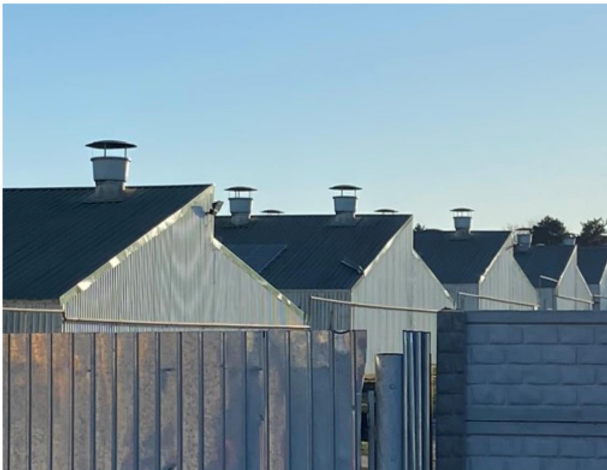
Panouri fotovoltaice pe hale
