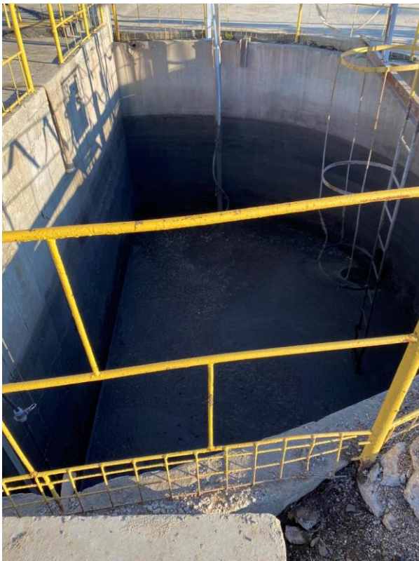
Batal nr. 1 reabilitat și bazin colectare dejectii mixte înainte de separare, nou realizat
