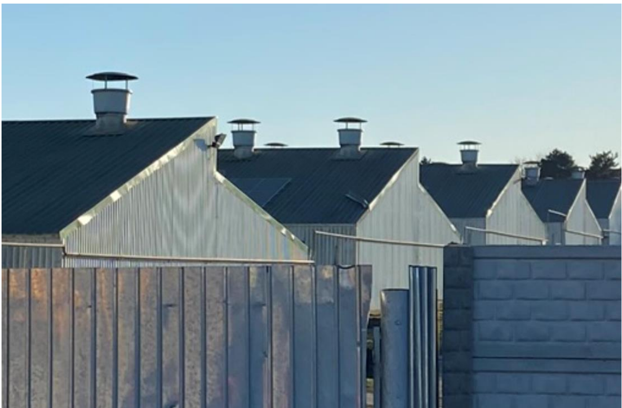
Panouri fotovoltaice pe hale
