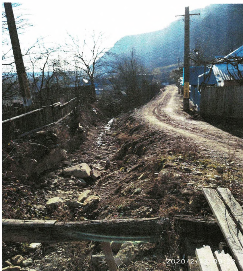
Fig. 4 Torent Pârăul Țiganului, zona aval
