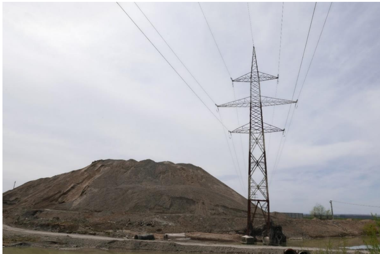
Fotografie realizata de sub deschiderea stâlp nr.209 - stâlp nr.210 – Spre stâlp nr.209
