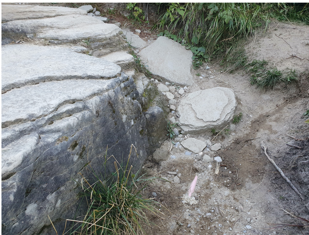
Foto 13. Aspect general al traseului LES 6 kV din imediata vecinătate a habitatului 4070* (foto E. Stoianov)
