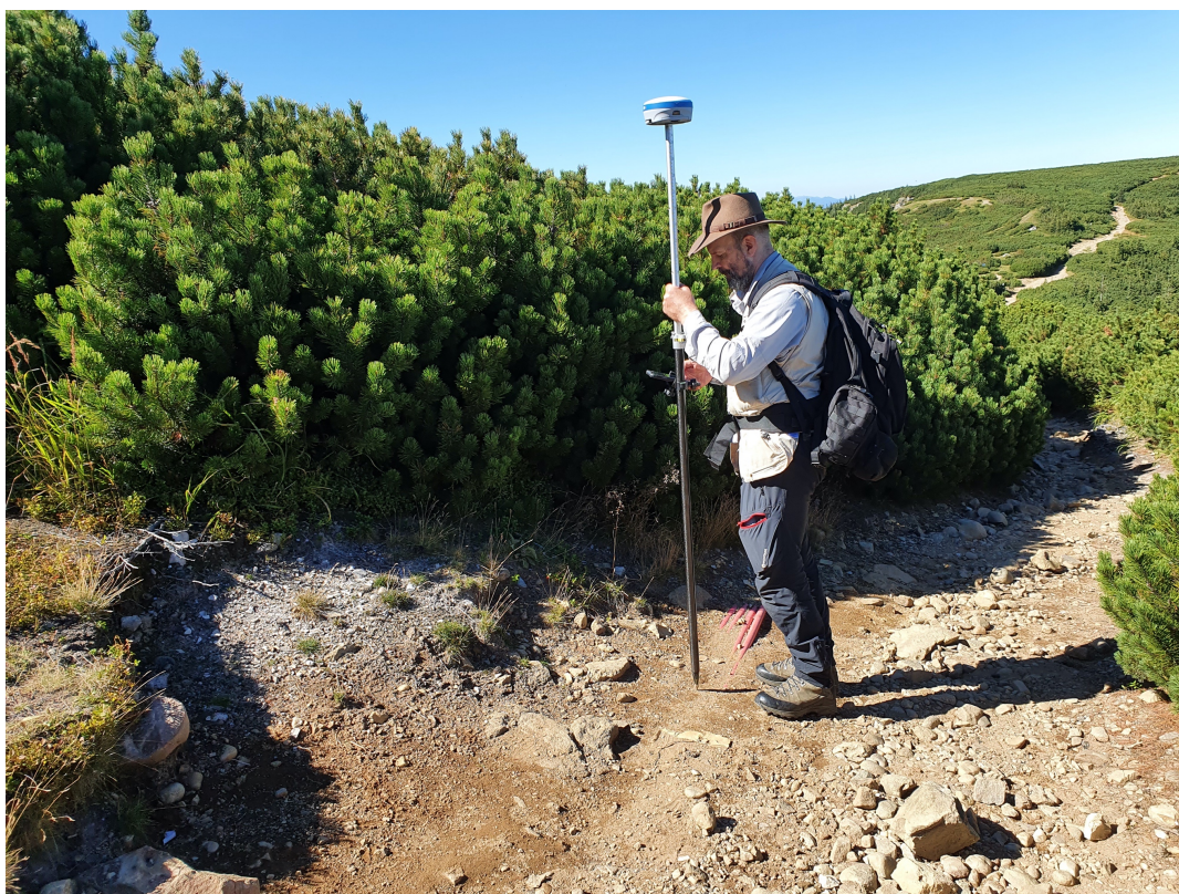
Foto 7. Aspect general al traseului LES 6 kV din imediata vecinătate a habitatului 4070* (foto E. Stoianov)
