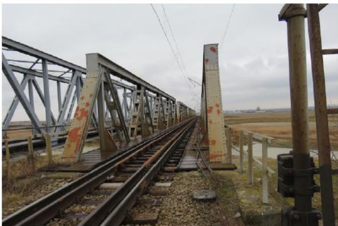
Pod km.343+714, pod existent cale simplă fir 2
