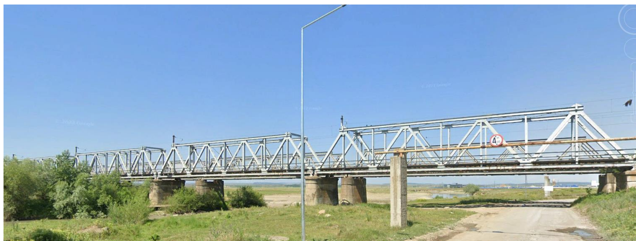
Figura - Pod km.343+714, linia de cale ferată Ploiești – Vicsani – zona culeei Roman
