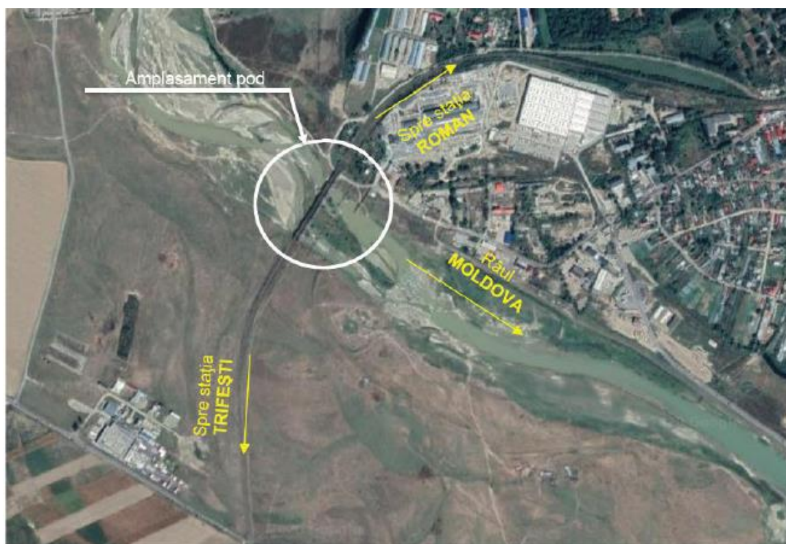
Figura – Pod cf existent km. 343+714 pe linia Ploiești - Vicsani
