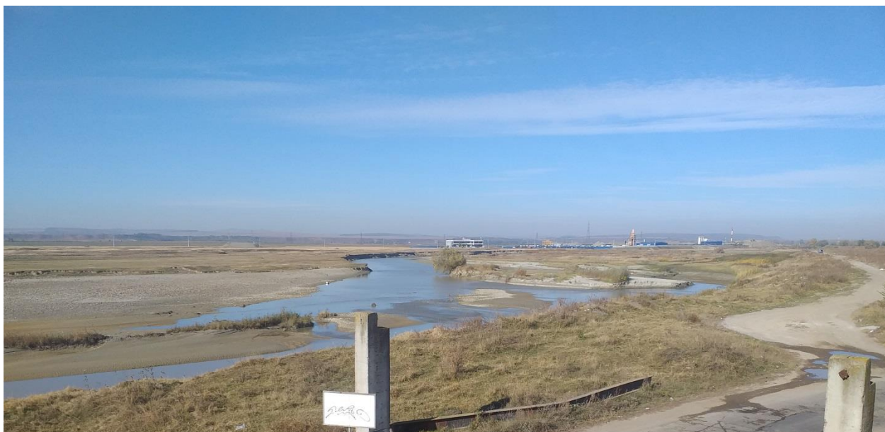
Figura - Albia râului Moldova amonte de pod km.343+71, linia Ploiești - Vicsani
