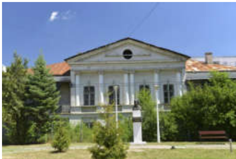
Fotografie 7 - Casa vornicului Done - Casa Sergiu Celibidache
