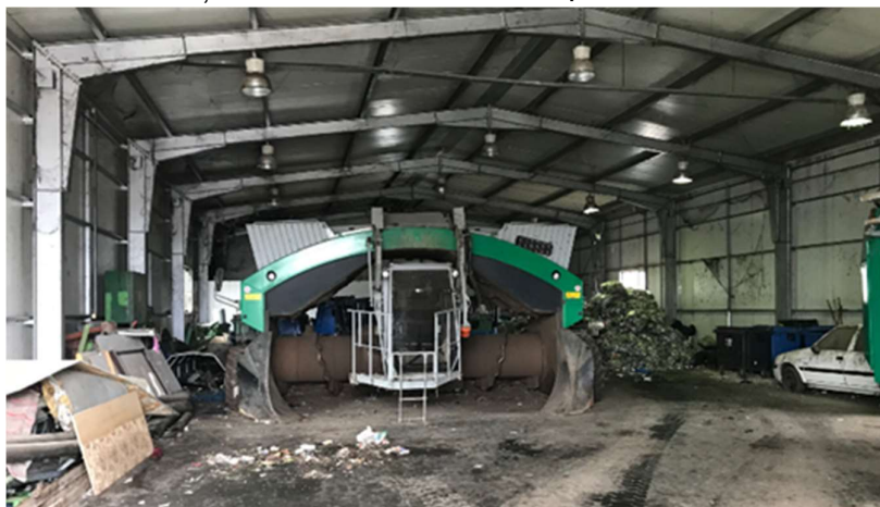
Figura 15 Garajul pentru echipamente
