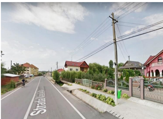
Supratraversare amonte pod pe stâlpi existenți
