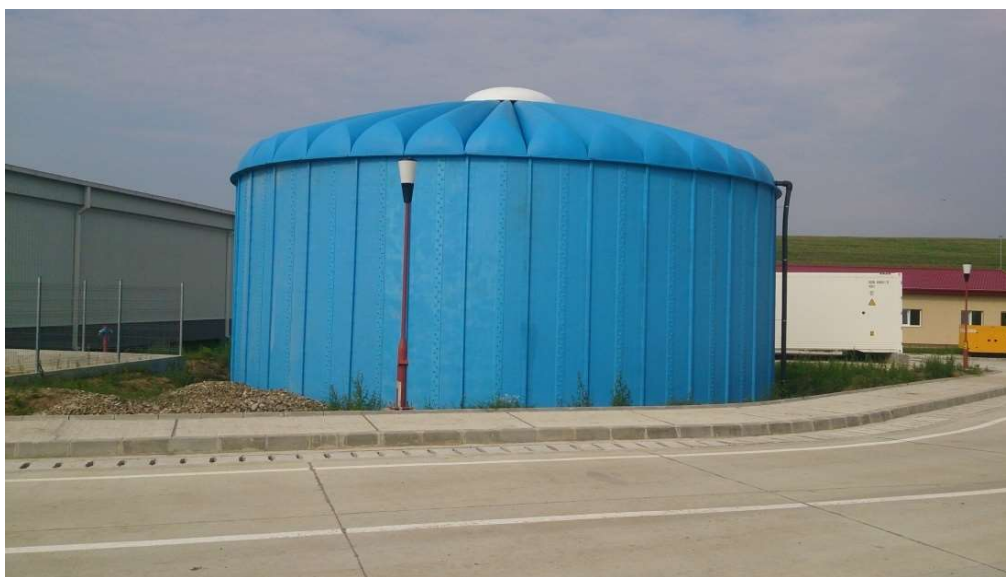
Foto nr. 11 – Rezervor stocare levigat
