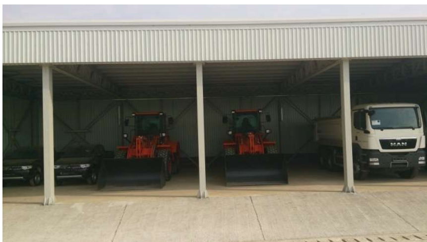
Foto nr. 6 – Garajul cu atelierul service
