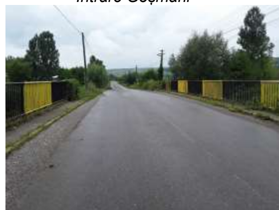
Figura 6 Pod pe D158 Siliștea
