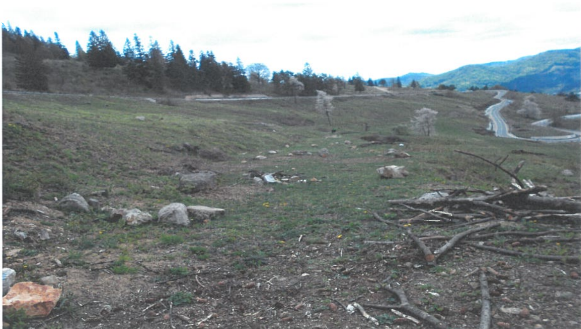
Foto. 3. Aspect cu traseul conductei între zona 2 și zona 3, între traversare 2 și 3 a DJ 157C. Traseu paralel cu traseul existent al conductei - teren primărie
