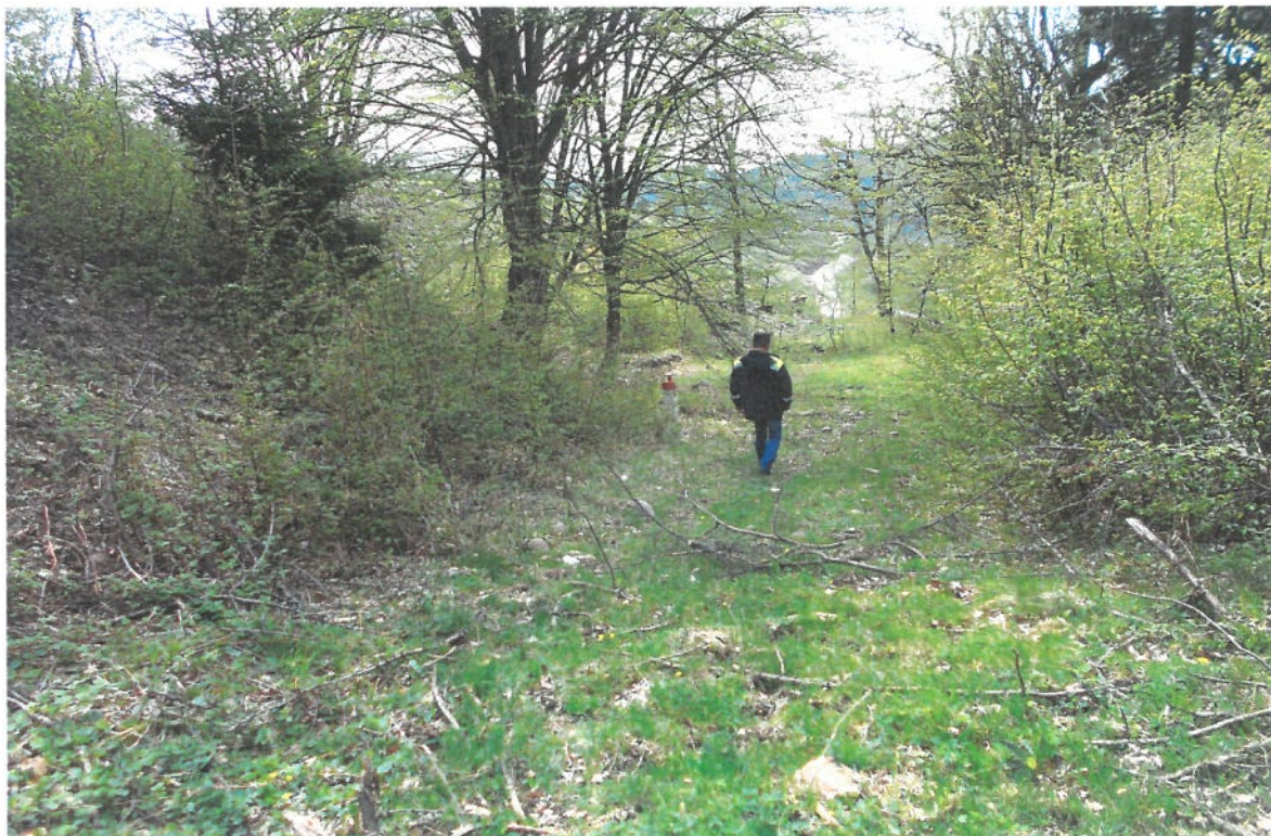
Foto. 4. Aspect cu traseul conductei între zona 2 și zona 3 - traseul conductei în apropiere de traversare 3 DJ 157C
