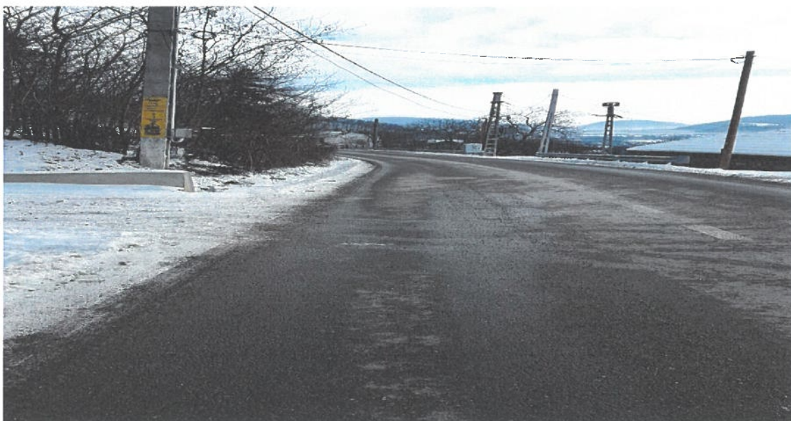
Foto. 1. Aspect din zona 1 - traversare DJ 157C – asfalt și rigolă ape pluviale pe dreapta DJ 157C executată pe traseul conductei
