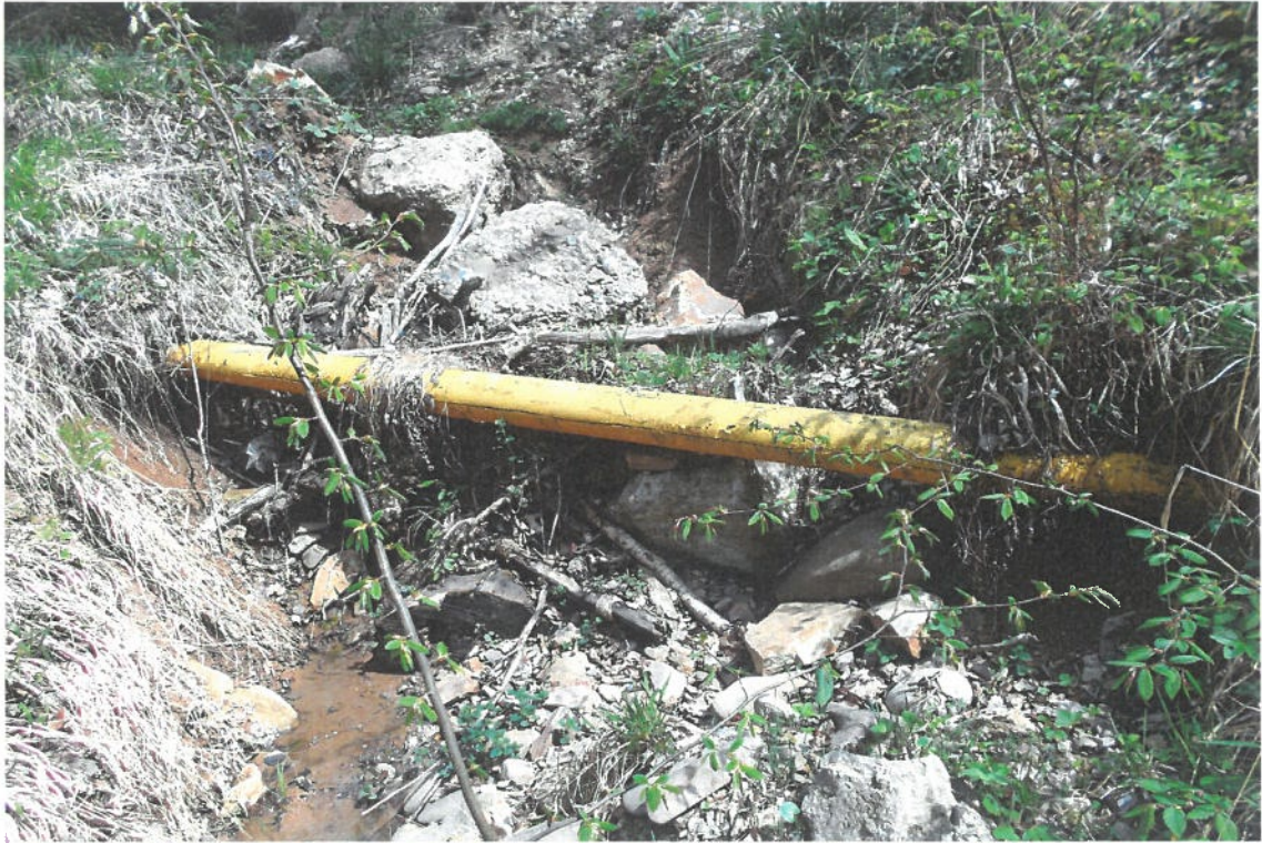
Foto. 6. Aspect din zona 3 - traseul conductei existente - traversare fir de vale în apropiere de schit Bisericani
