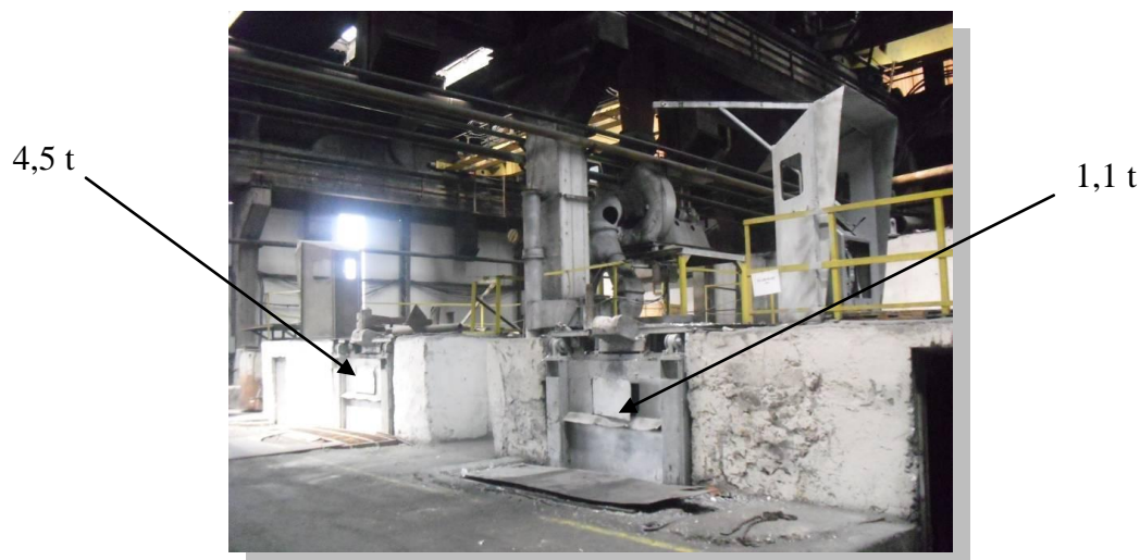
Figura 8 - Cuptoare electrice cu inducție
