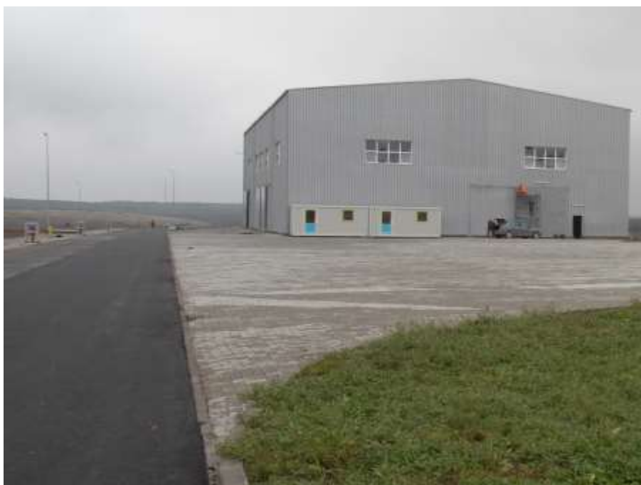
Imaginea arată fațadele de sud și vest ale halei Stației de sortare
