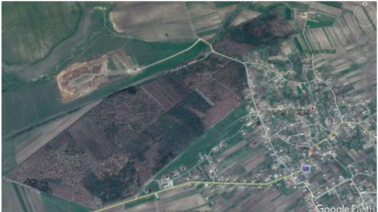
Imagine a amplasamentului din timpul execuției lucrărilor
