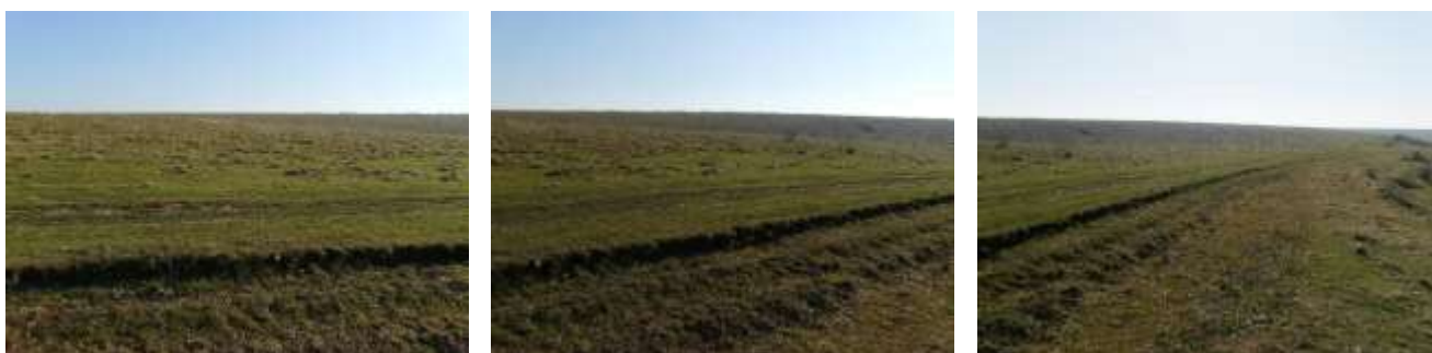
Privire de pe marginea din partea de N a amplasamentului spre SV, incluzând partea centrală înainte de începerea lucrărilor
